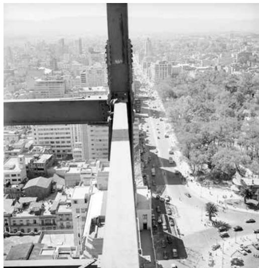
Estructuras de hierro para la construcción de la Torre Latinoamericana, panorámica Fotografía: Nacho López, octubre de 1951 Inv. 374761 Sinafo.Secretaría de Cultura.INAH.MX
